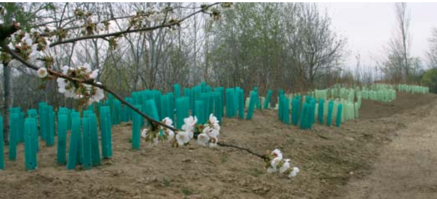
Fase di sistemazione e rivegetazione delle sponde
