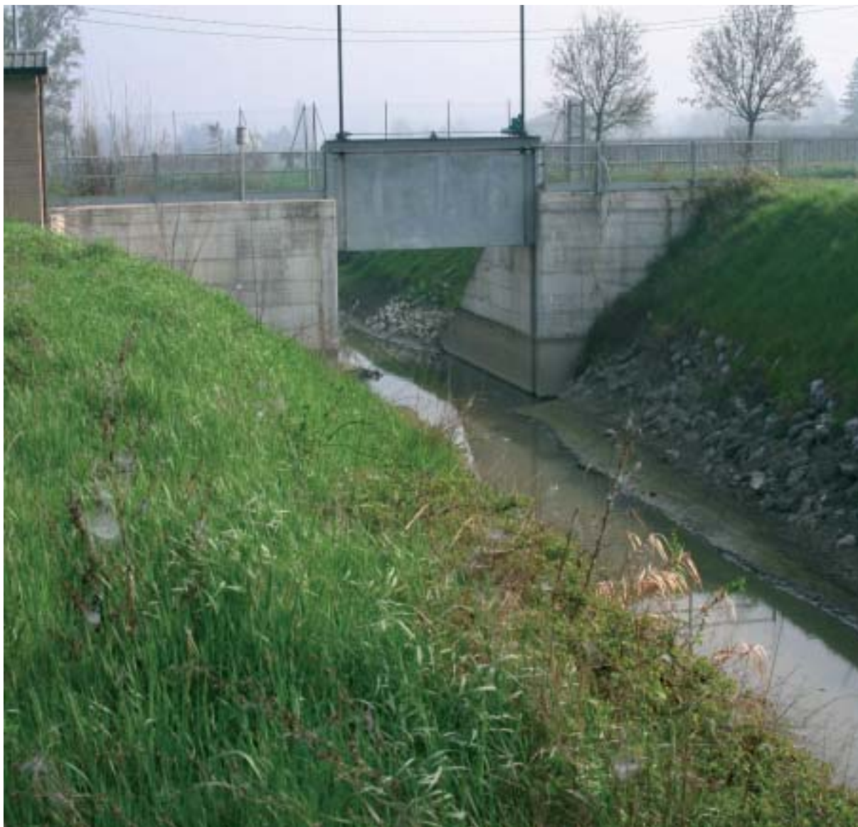
Chiusa per la regimazione delle acque del Cavo Naviglio
