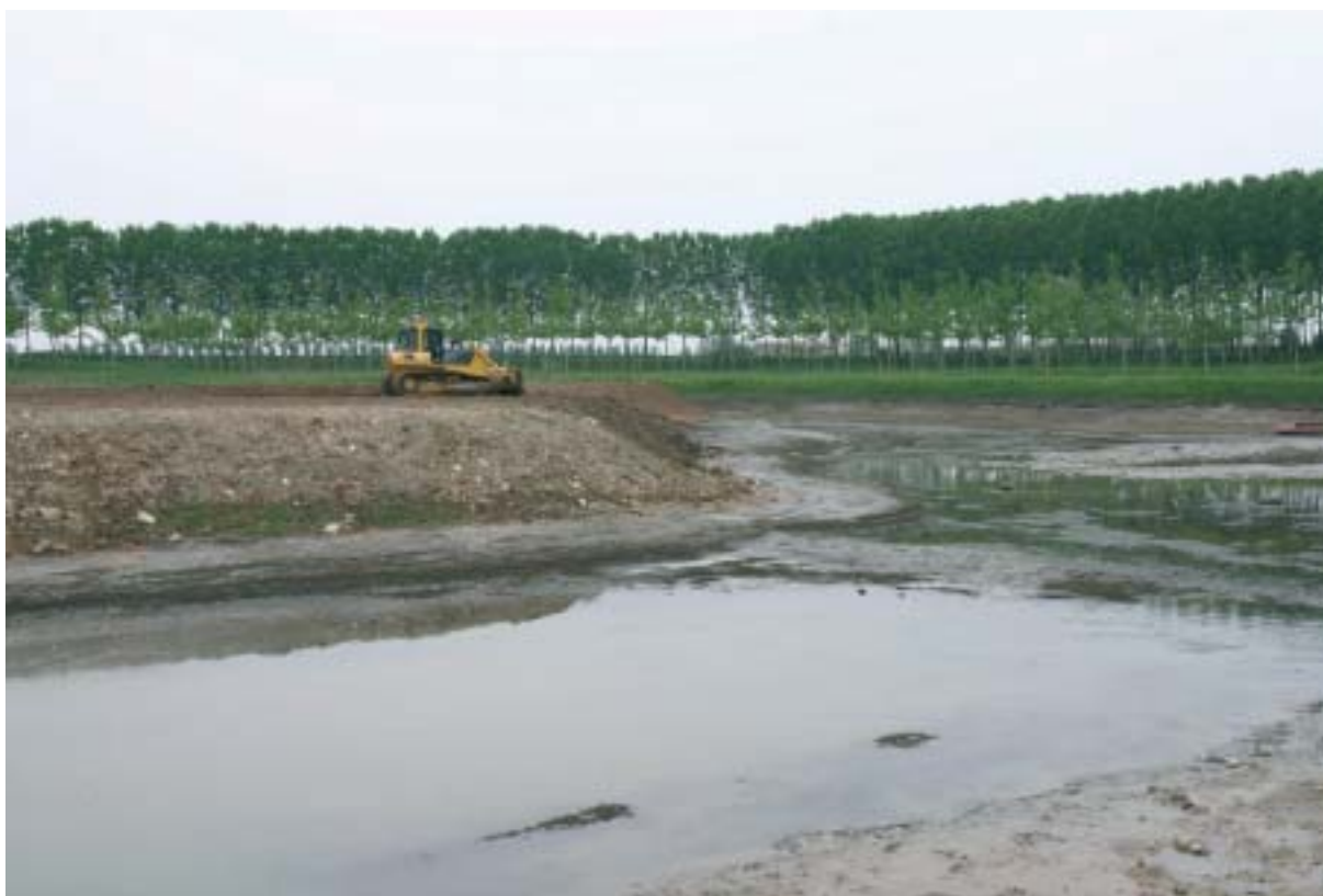
Cava Casino Riva – Fase di tombamento con inerti
