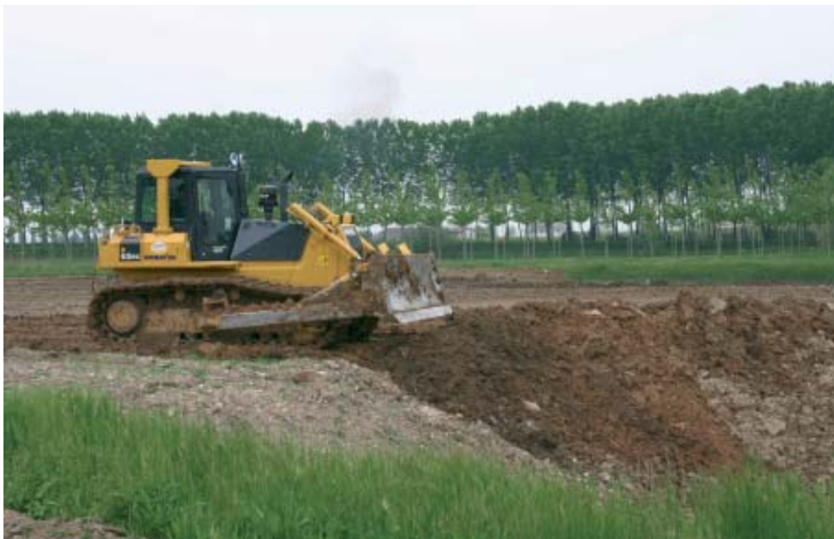
Cava Casino Riva – Dettaglio fase di tombamento
