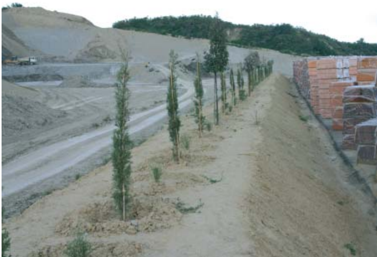
Realizzazione di una barriera vegetale con la messa a dimora di piante alto-arbustive
