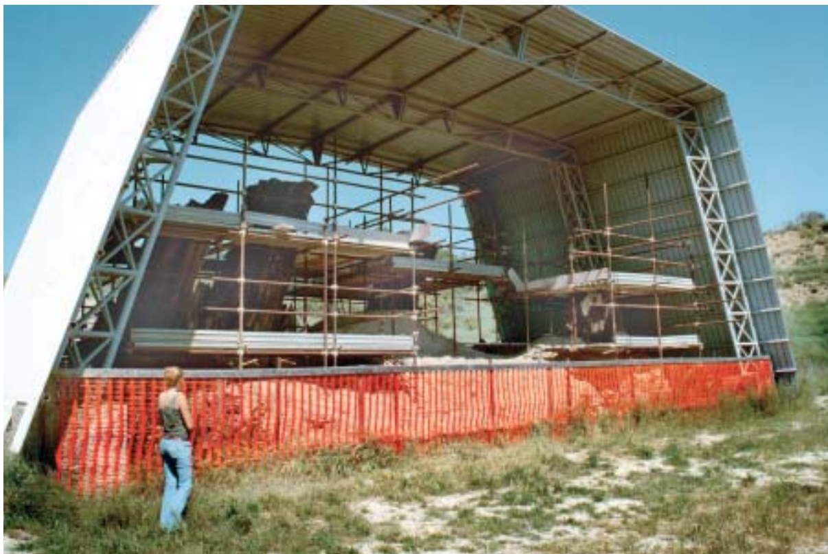
La grande struttura protettiva
