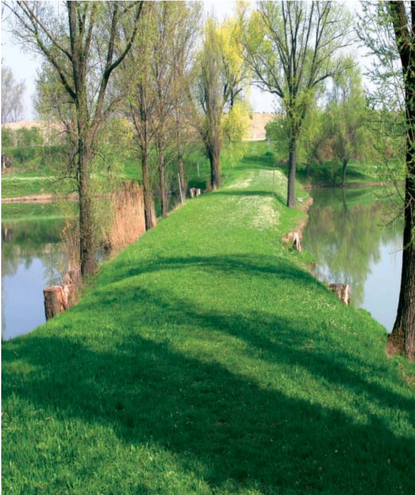
Modellazione e consolidamento delle sponde con essenze igrofile
