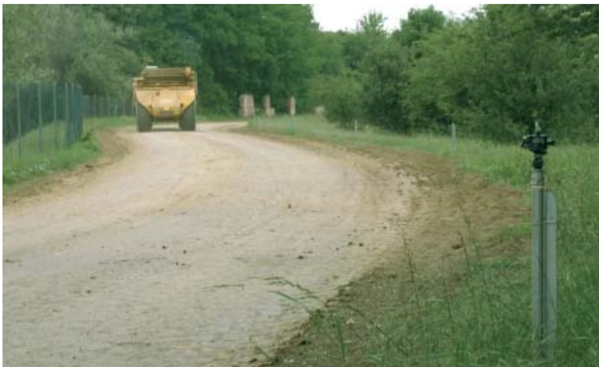
Impianto fisso di bagnatura lungo il percorso di servizio della cava
