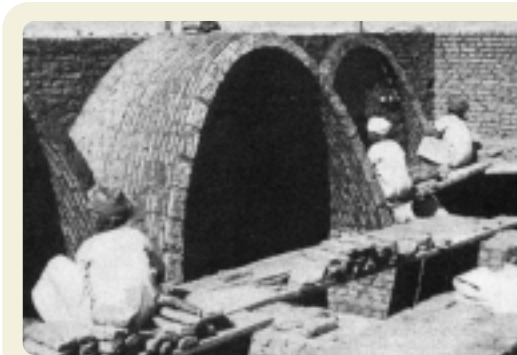
SEQUENZA DELLA COSTRUZIONE DI UNA VOLTA A CORSI INCLINATI CHE SI APPOGGIANO A UN MURO DI FONDO
