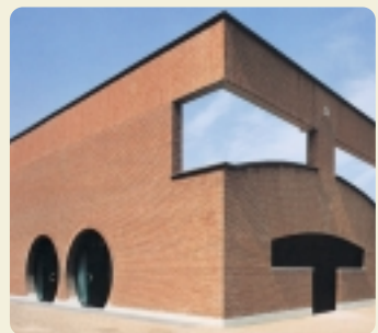
MARIO BOTTA, EDIFICIO A FIRENZE
