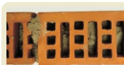
IL CORRETTO COSTIPAMENTO DEI GIUNTI È FONDAMENTALE SE SI USANO MATTONI FORATI
