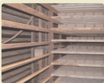
UNA VENTOLA MOBILE FA CIRCOLARE L'ARIA NELL'ESSICCATOIO
